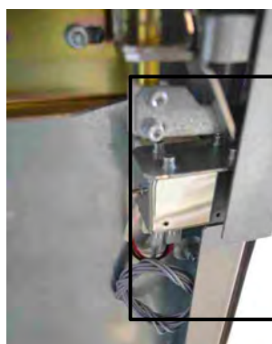
Электромагнитная блокировка заземлителя
