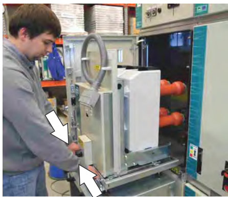
Сдвигайте 2 замковые ручки одновременно к центру
