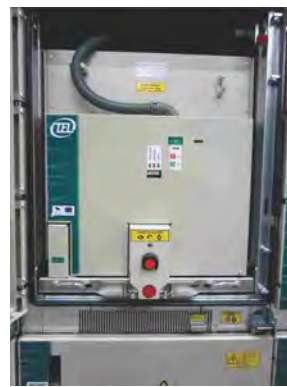
ВЭ в изолированном положении
