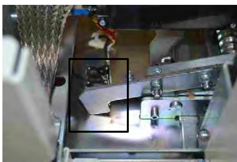
Шток электромагнита втянут, запирающая скоба опущена, возможно крутить ручку управления ВЭ (оперативное питание подано)
