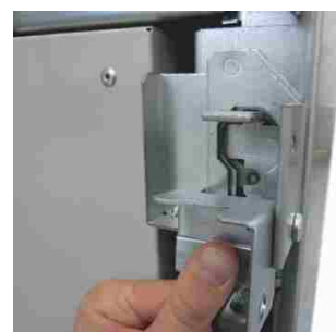
Шторка и гнездо управления заземлителем
