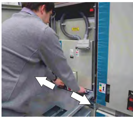
Толкайте ВЭ до конца, пока он не зафиксируется замками в торцах ячейки
