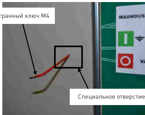
Аварийное открытие двери ячейки LBSF
