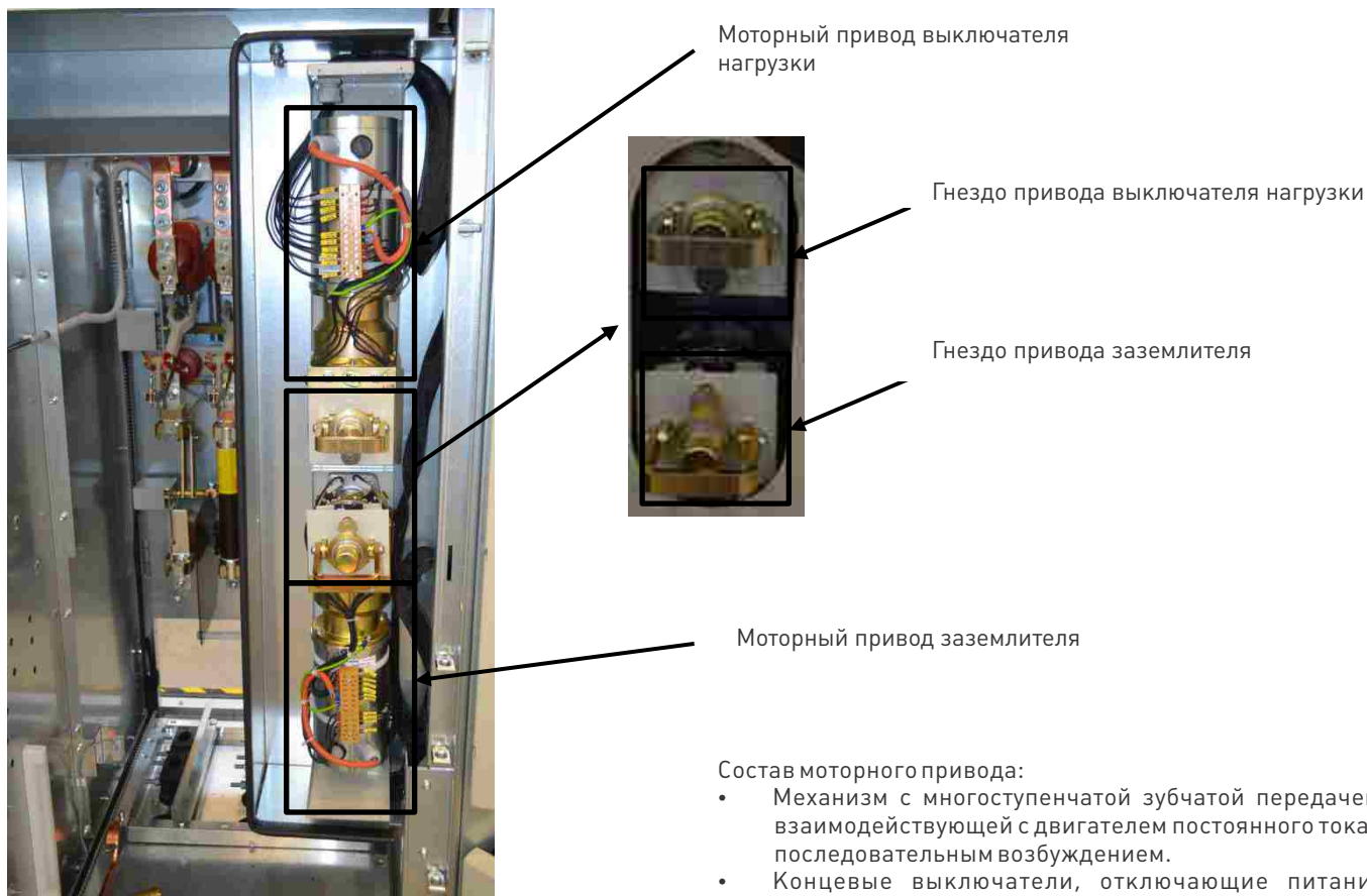
Ячейка LBSF с моторными приводами для выключателя нагрузки и для заземлителя
